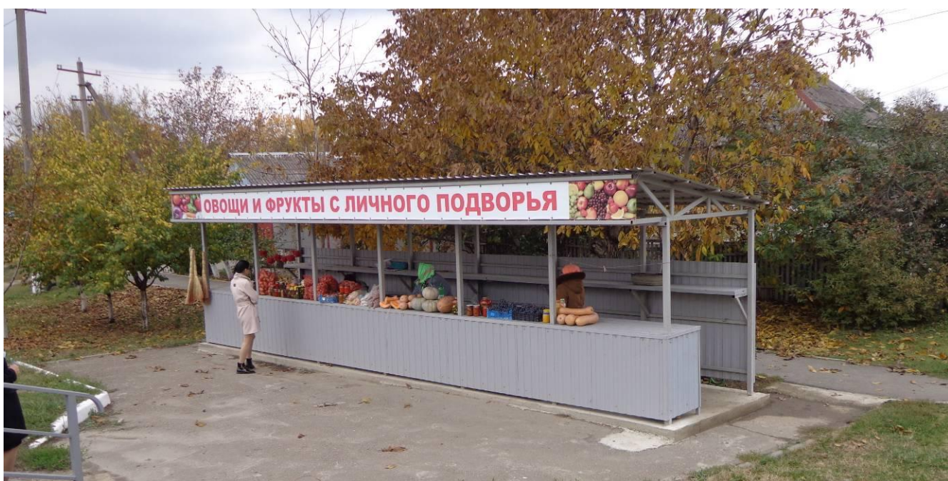
Рис. 59 – Автомобильная дорога «г. Славянск-на-Кубани - г. Крымск», км 23+482 справа, Крымский район
