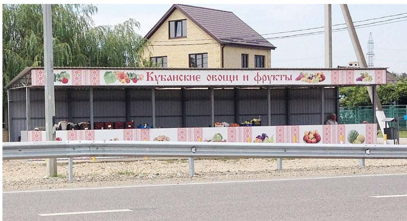
Рис. 60 – Федеральная автомобильная дорога А-146 «Краснодар – Верхнебаканский», км 105+600 слева, Крымский район
