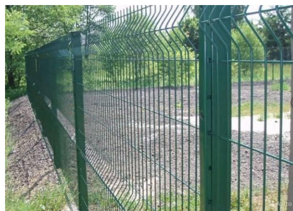
Сварные секционные металлические ограждения
