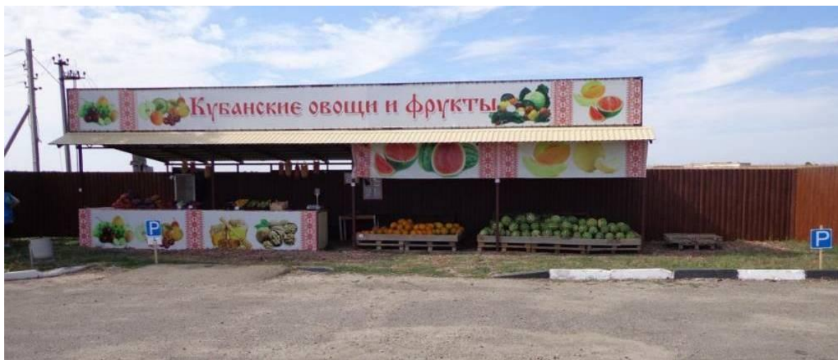
Рис. 15 – Автомобильная дорога «ст-ца Стародеревянкoвская – ст-ца Ленинградская – ст-ца Кисляковская», км 36+100 слева, Ленинградский район
