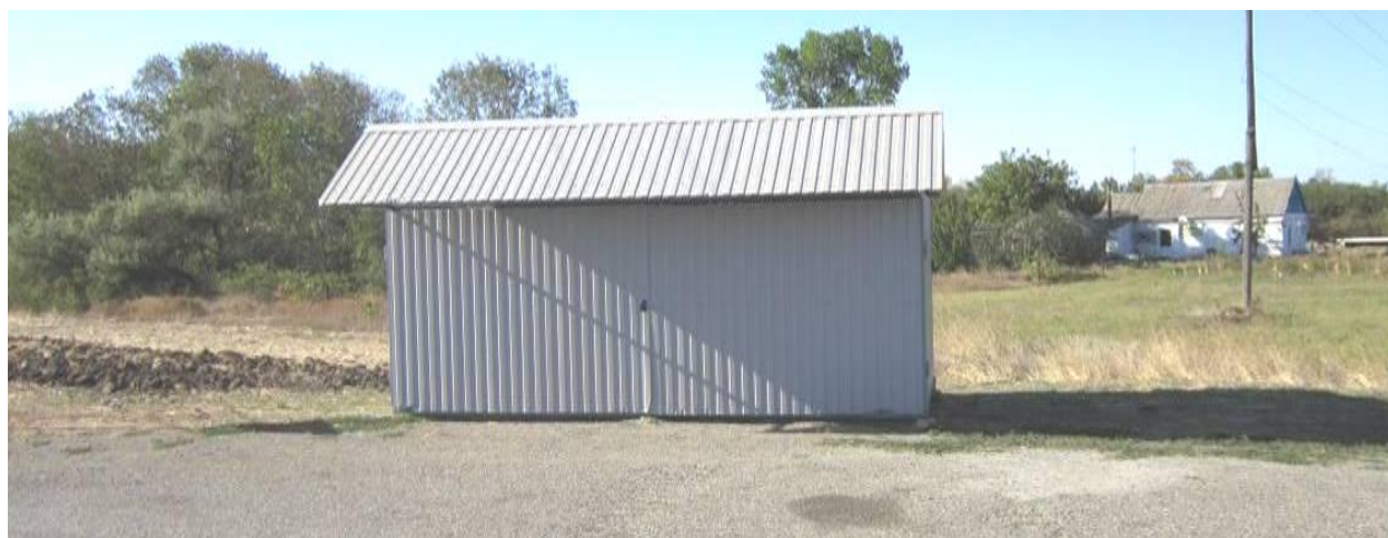
Рис. 53 – Автомобильная дорога «г. Краснодар – г. Ейск», км 213+582 справа, Щербиновский район
